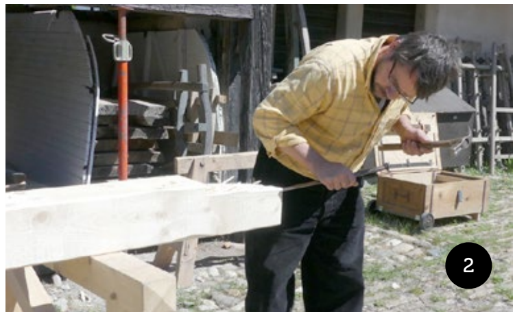
Julien Hubin sur le chantier d'Ittenheim
