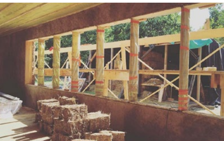
Vue de l'intérieur de la structure
