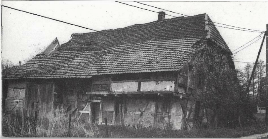
La maison-bloc de 1768 à Muespach avant son démontage...
