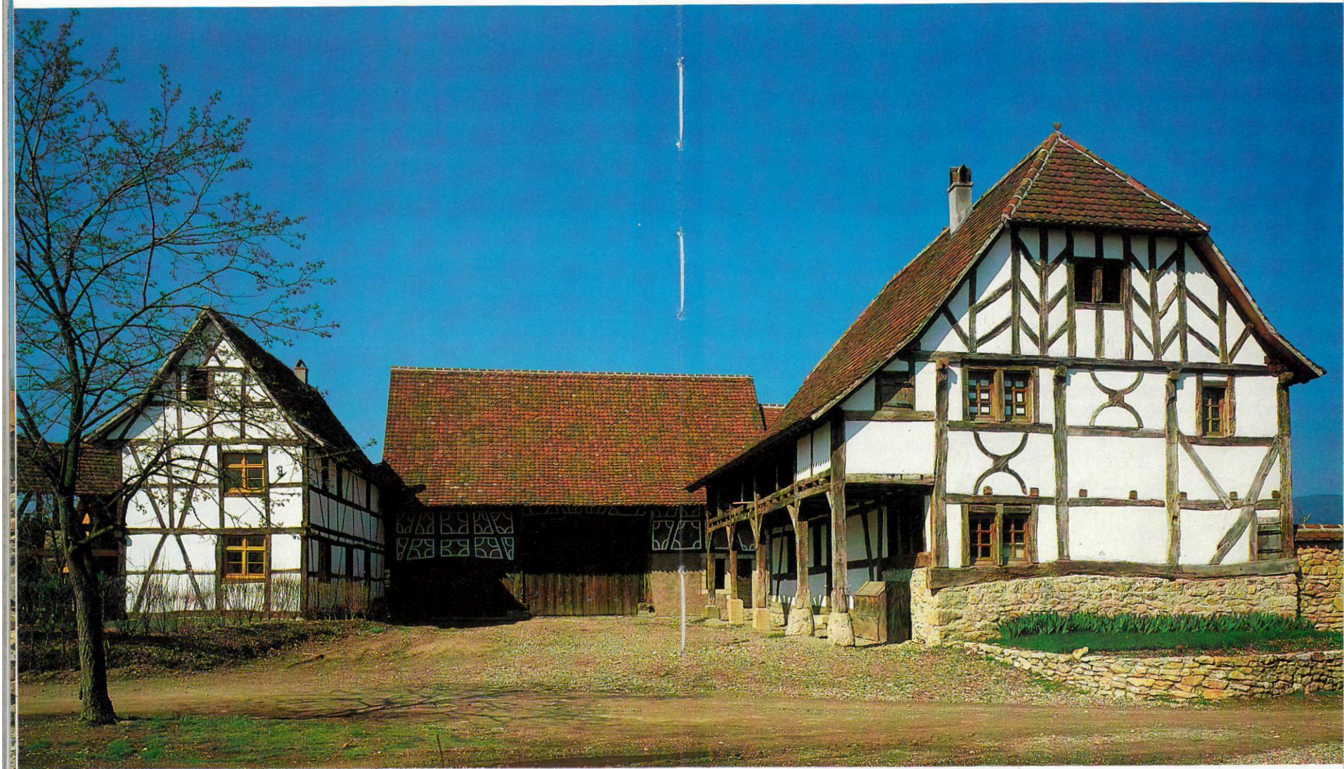
Vue d'ensemble de la ferme-cour du Sundgau, montrant bien la disposition d'ensemble en U. L'habitation tourne son pignon vers la rue ; la grange, dont les trois travées sont bien visibles ici, occupe le fond de la cour.
