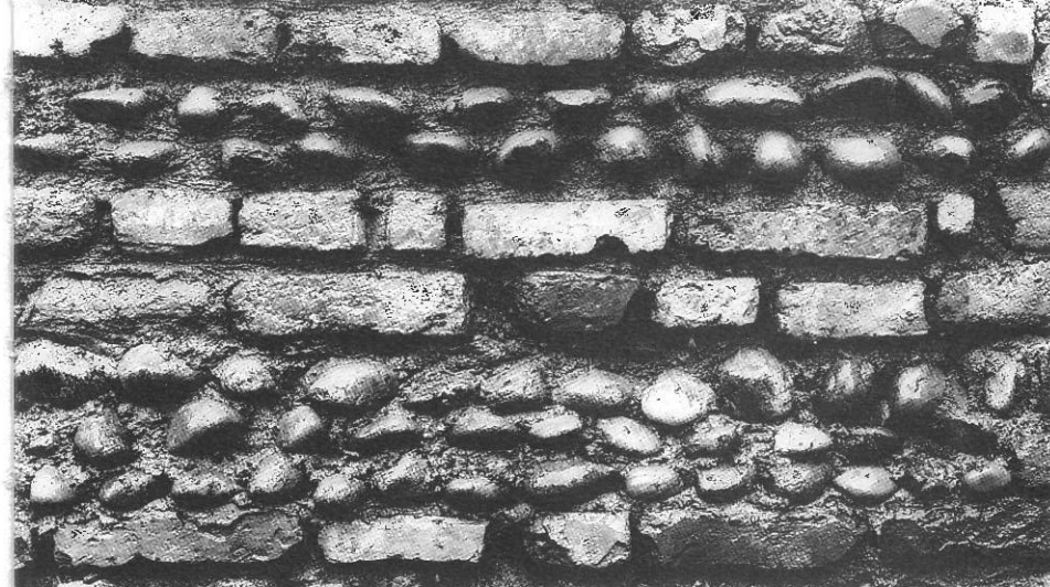
Mur d'enceinte en galets alternés avec des assises de briques.
