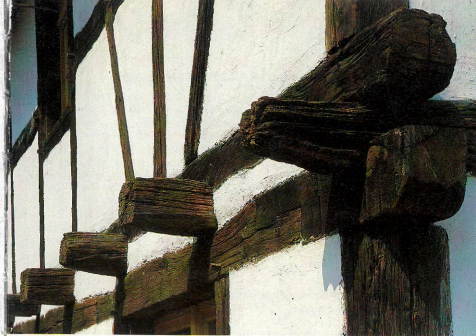
Façade arrière de la dépendance de Buschwiller : les débords des solives qui recevaient la toiture initiale avant surélévation.
