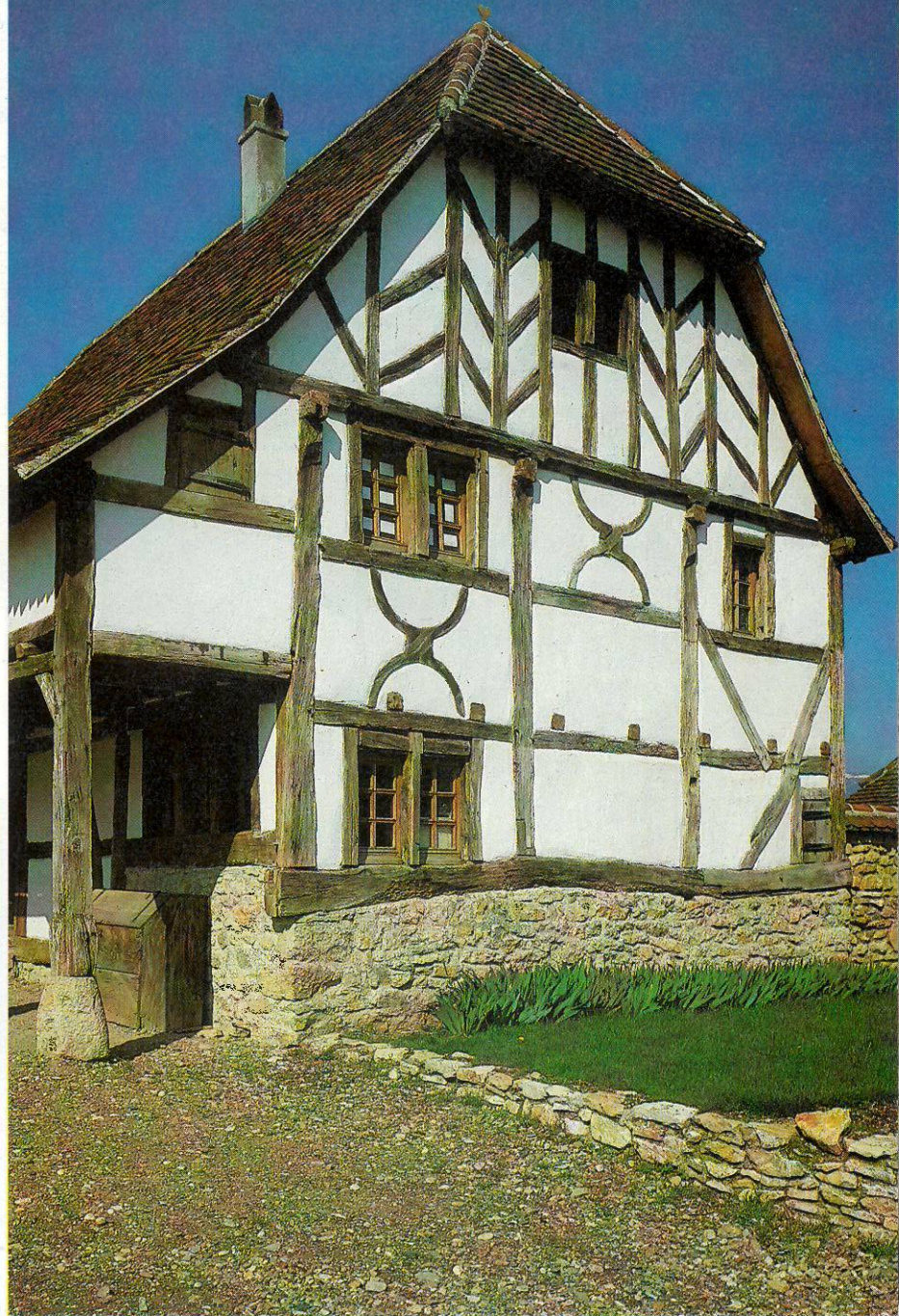
Maison de 1574, provenant de Héisingue. Très intéressante par sa galerie latérale sur poteaux, servant en partie de pigeonnier, et surtout par son pignon au rare colombage en épis. Remarquer aussi les croix de Saint-André d'inspiration gothique avec leurs branches courbes, et l'inégalité entre les fenêtres. Cette maison forme l'habitation de la « ferme-cour » du Sundgau.
