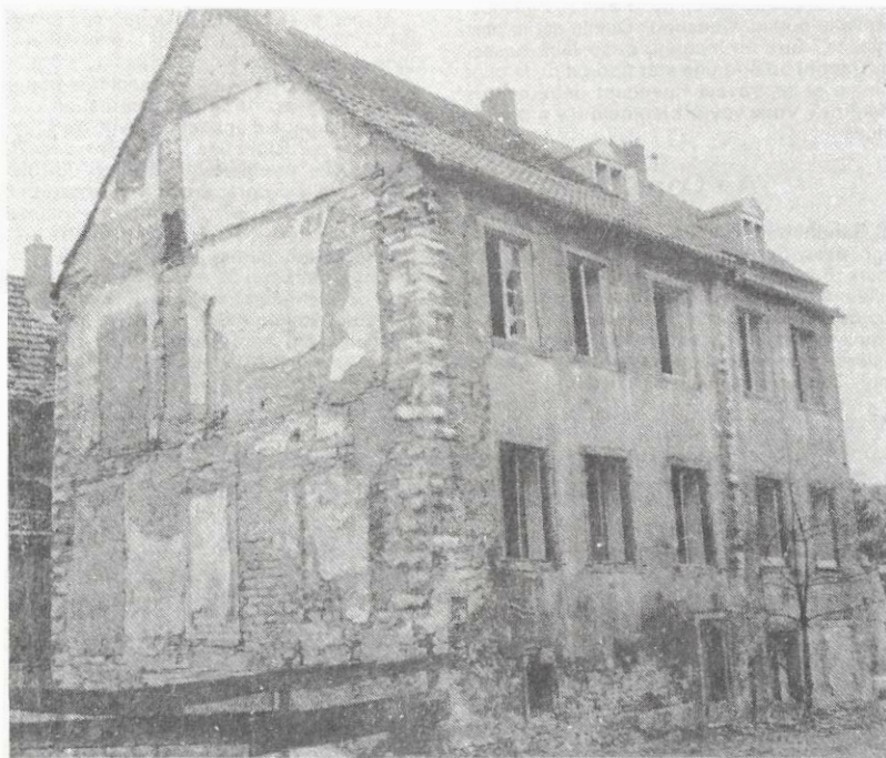
Les vestiges de la Maison-Forte de Mulhouse avant la démolition, et en cours de reconstruction à l'Ecomusée.
