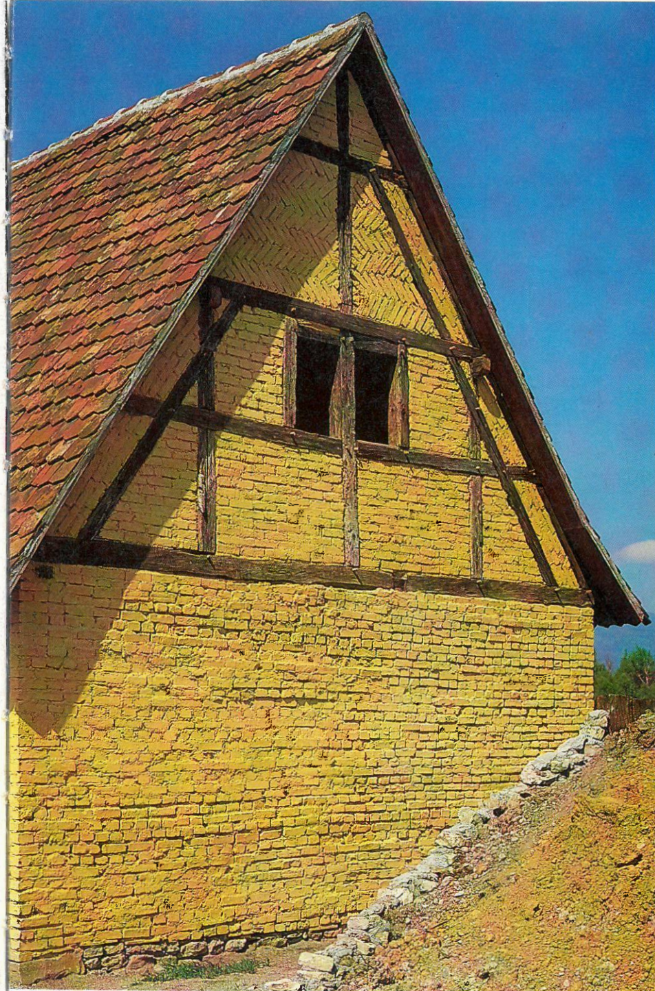
Le pignon médiéval de Turckheim. Disposition simple et très géométrique du colombage. La pièce oblique, parallèle au rampant de la toiture, est un élément caractéristique du colombage médiéval ; elle est assemblée à mi-bois et queues d'arondes à ses extrémités. Remplissages en briques ; remarquer l'appareillage en « arête de poisson » dans la partie supérieure.
