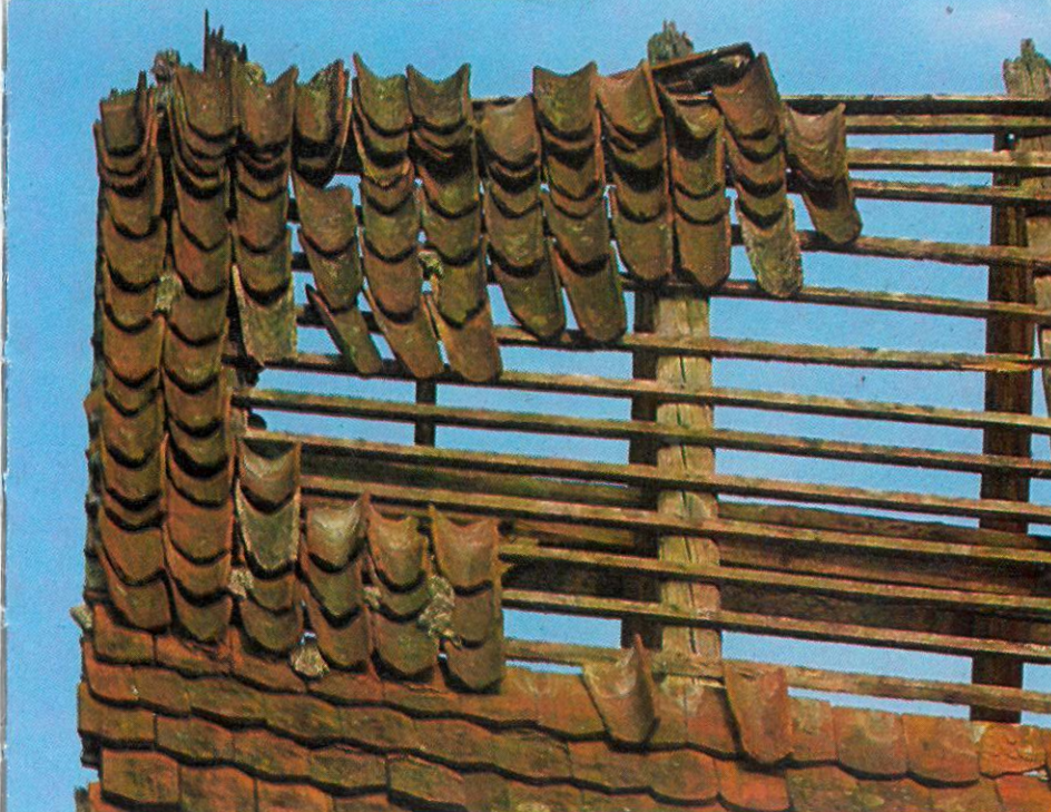
Tuiles plates « Biberschwanz » et tuiles canal sur un même toit. Les tuiles canal, d'origine romaine, sont devenues extrêmement rares. Leurs joints recevaient une tuile de recouvrement ou un filet de mortier.
