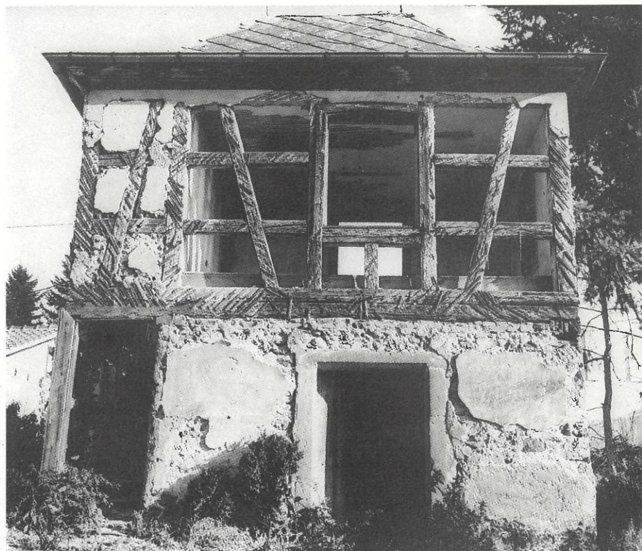
Le pavillon de Ribeauvillé au cours de son démontage en 1979.
