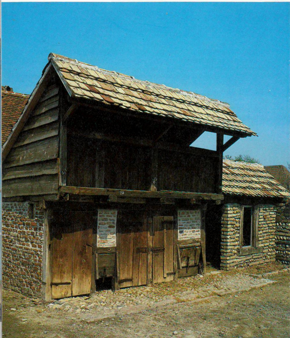
Bâtiment accessoire dans la cour de ferme de la plaine, abritant porcherie et latrine.
