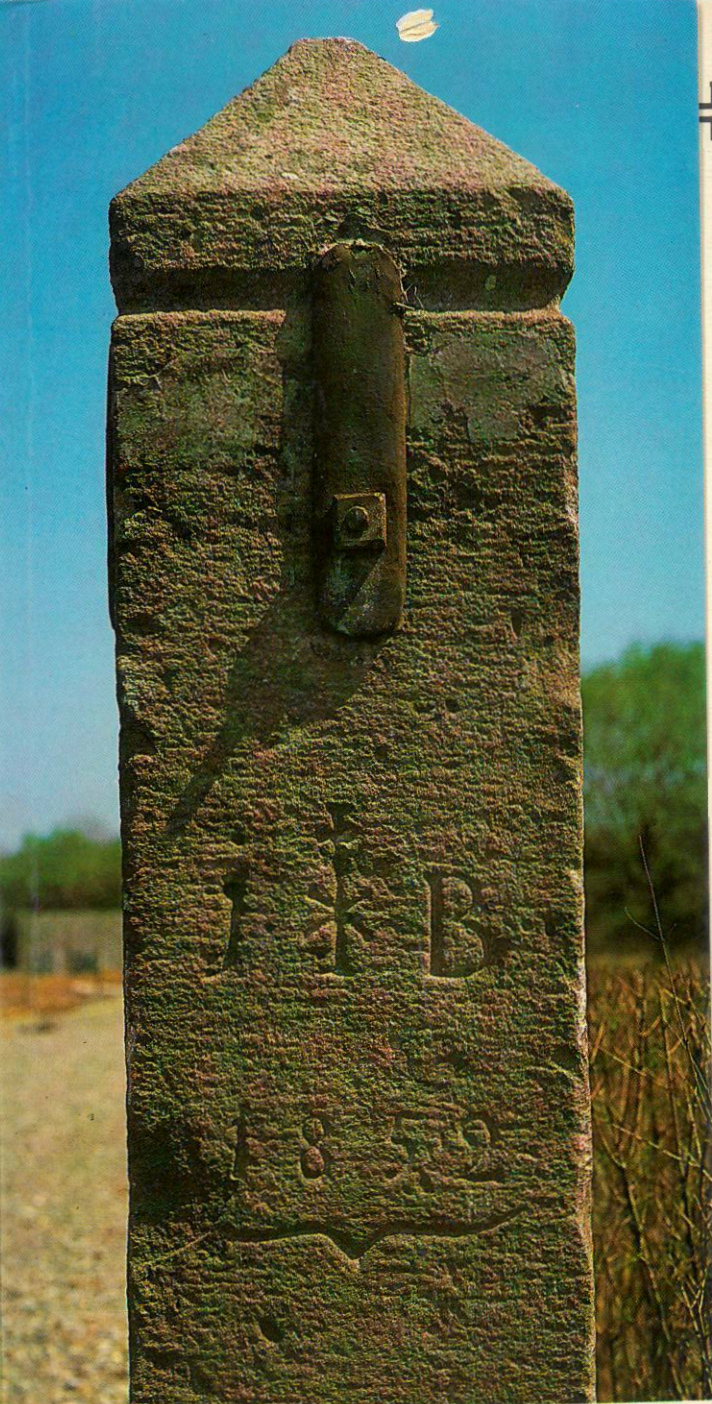
Poteau de portail. Ces poteaux de grès rouge ou jaune portent les vantaux des portes de cours de ferme dans toute l'Alsace. Autrefois équipement coûteux, sinon de prestige, ils sont les supports d'inscriptions : dates, noms, initiales... Ici la date 1852 et un « Hofzeichen ».
