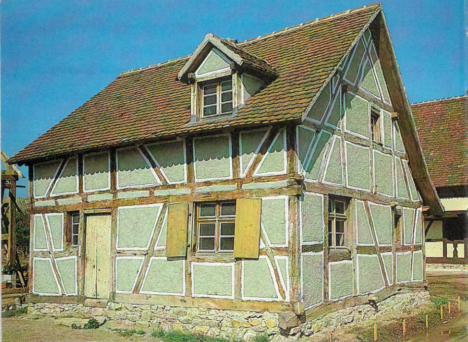
La construction la plus humble à l'Ecomusée : petite habitation de journalier de Koetzingue (début XIX e siècle) surélevée d'un côté.
