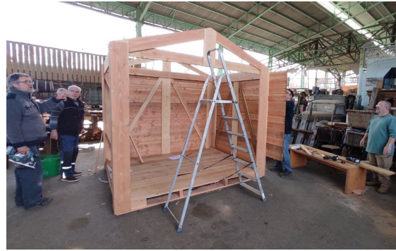
La construction de chalets en bois bat son plein.
