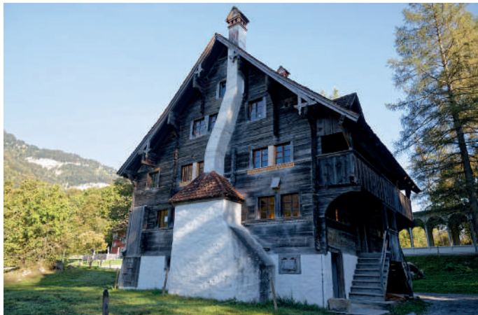
Curieuse cheminée extérieure
