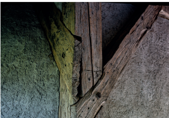
Les assemblages sont particulièrement élaborés.
