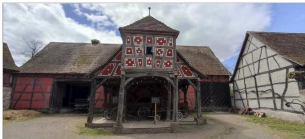
Sur le pigeonnier d'Oberhergheim, qui penche à droite, des poutres ont été réparées avec de la résine, des fissures sont apparues, la pourriture se développe... Photo L'Alsace/Olivier BRÉGEARD
