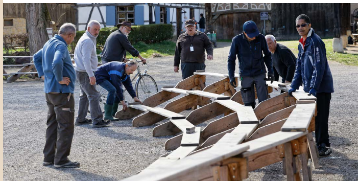
Mise en place des gradins.
